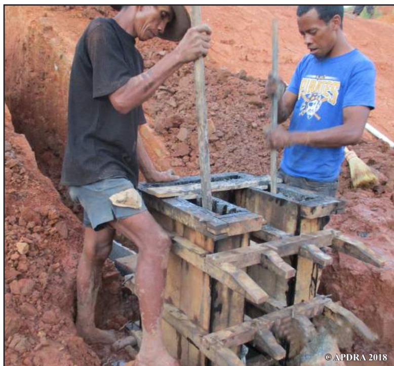
Mise en place du moine de l'étang barrage
